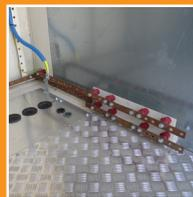
**La mise à la terre :** le circuit de mise à la terre des masses est de 30 mm<sup>2</sup>.
